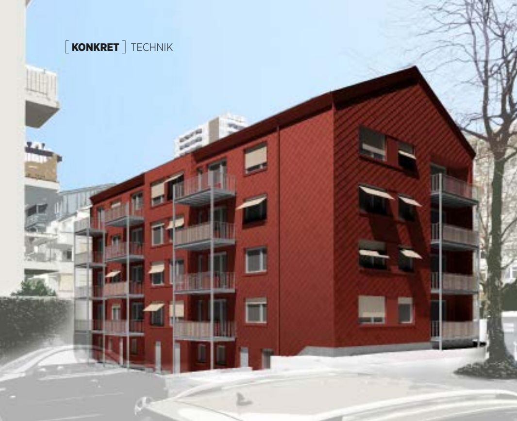
Mehrfamilienhaus in Köln: Bei dem Projekt von Zeller Kölmel Architekten begannen vor Kurzem die Bauarbeiten. Intelligente Planung und Vorfertigung senken die Mieterbelastung.
