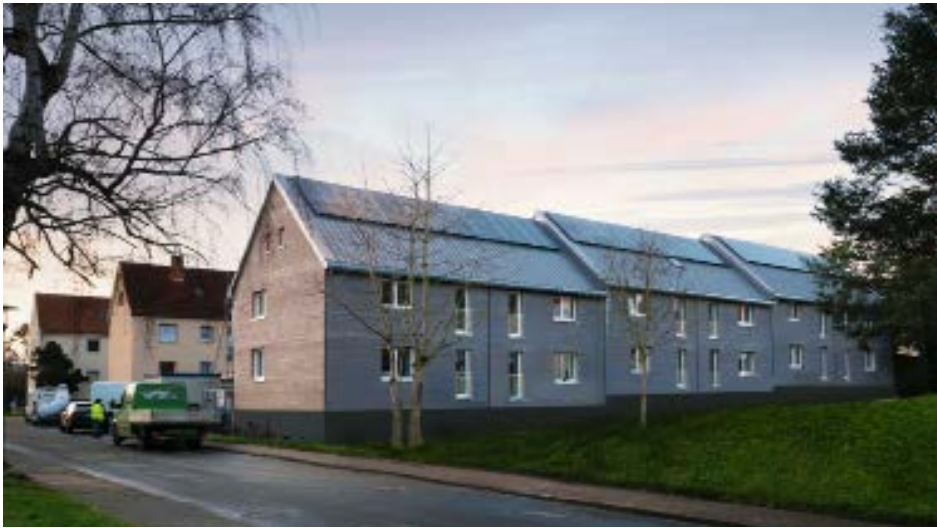
Pilotprojekt in Hameln: Die drei Häuser wurden mit vorgefertigten Dach- und Fassadenelementen sowie nachhaltiger Heiztechnik und Stromerzeugung auf Net-Zero-Standard gebracht.
